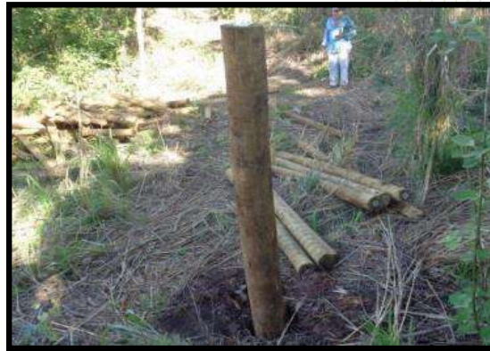
Figura 5.6 – Encaixe dos mourões esticadores. Fonte: LOCALMAQ (2017)
