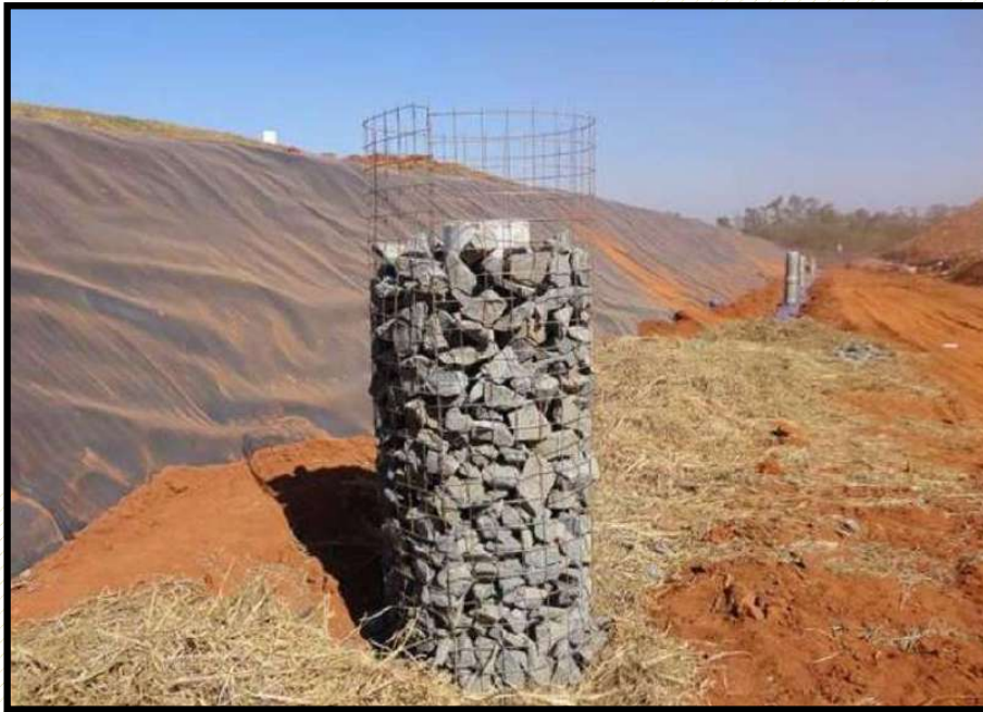
Figura 5.9 – Estrutura de Drenagem dos Gases. Fonte: Google, 2021
