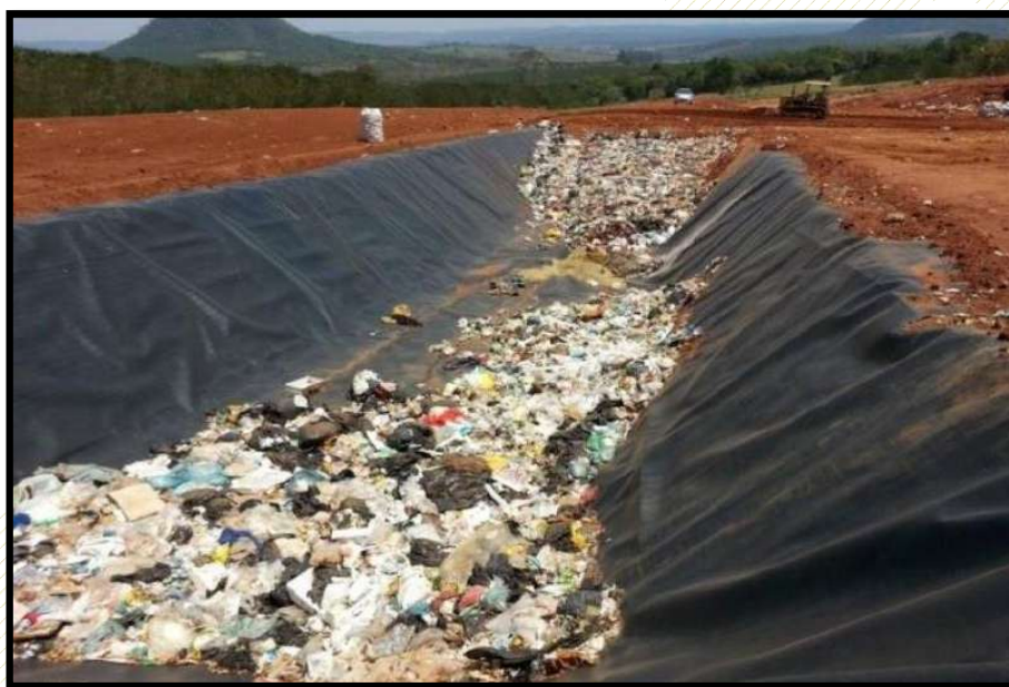
Figura 5.4 – Vala de resíduos com manta PEAD. Fonte: Google imagens, 2021
