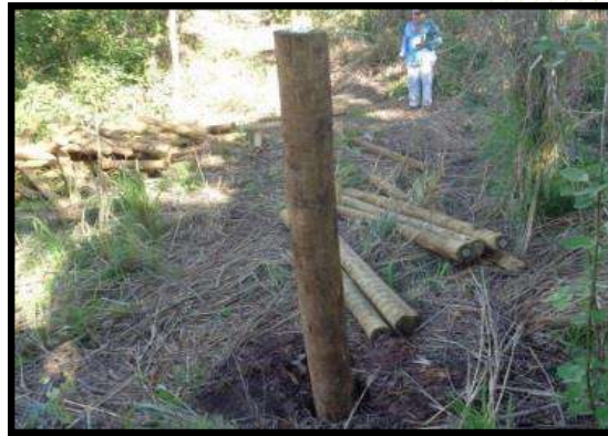
Figura 5.6 – Encaixe dos mourões esticadores. Fonte: LOCALMAQ (2017)
