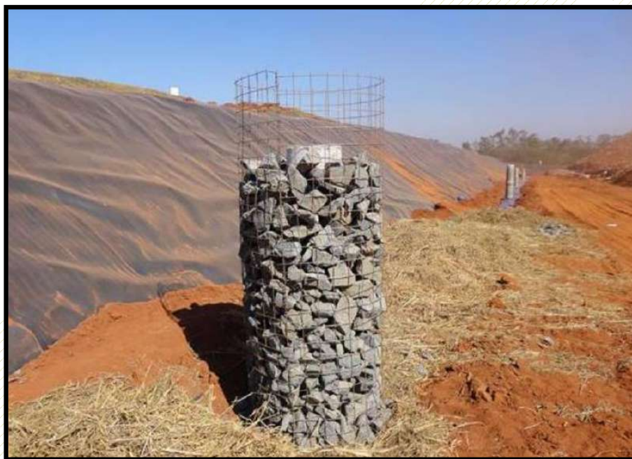
Figura 5.9 – Estrutura de Drenagem dos Gases. Fonte: Google, 2021
